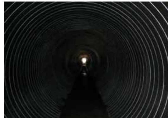
Das fertig gestellte SPR™ PE-Rohr mit den eindeutig sichtbaren Schweißverbindungen
