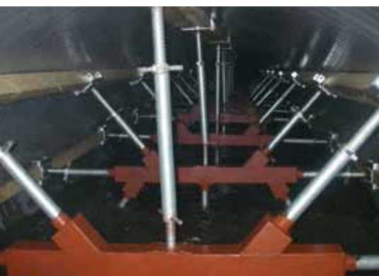
Stützrahmen während der Ringraumverfüllung
