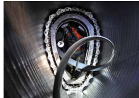
Sanierung Eiprofil
