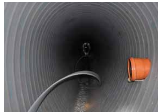
Einbindung der Hausanschlüsse während des Wickelvorgangs
