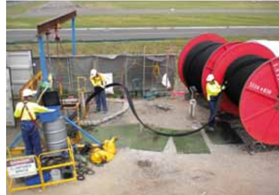
SPR™ PE jobsite.
